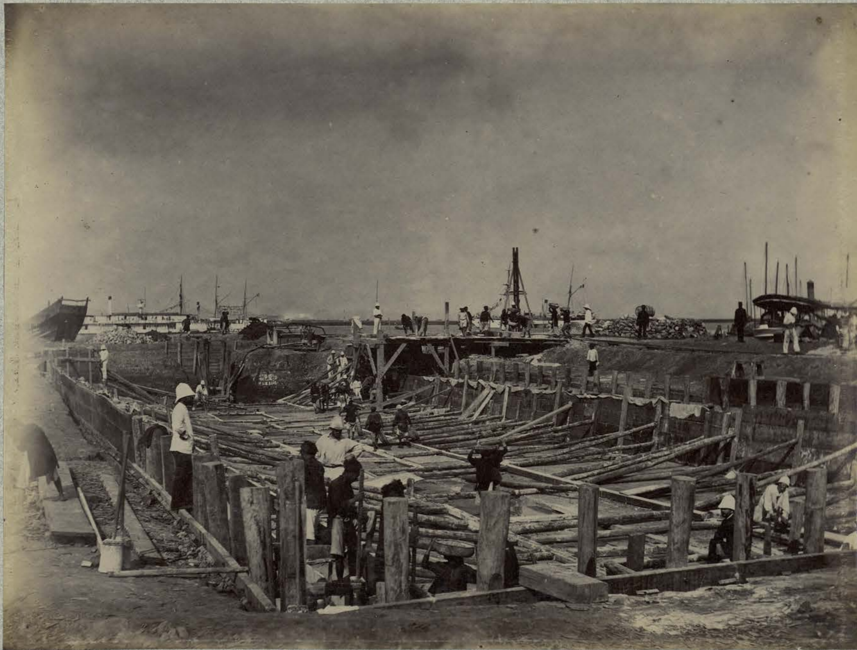
Construction du bassin de radoub pour les canonnières. Haïphong.
