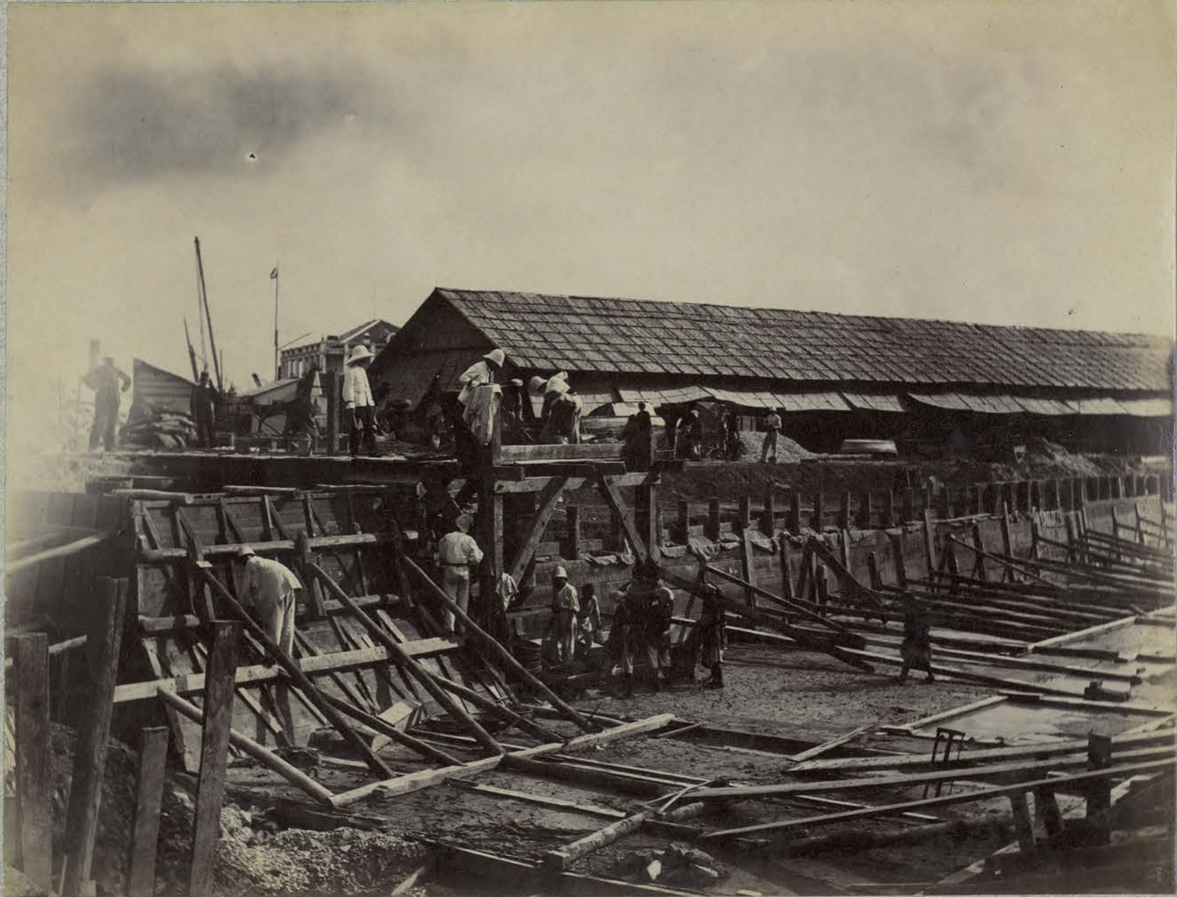
Construction du bassin de refroidissement pour les centrales. Haiphong.
