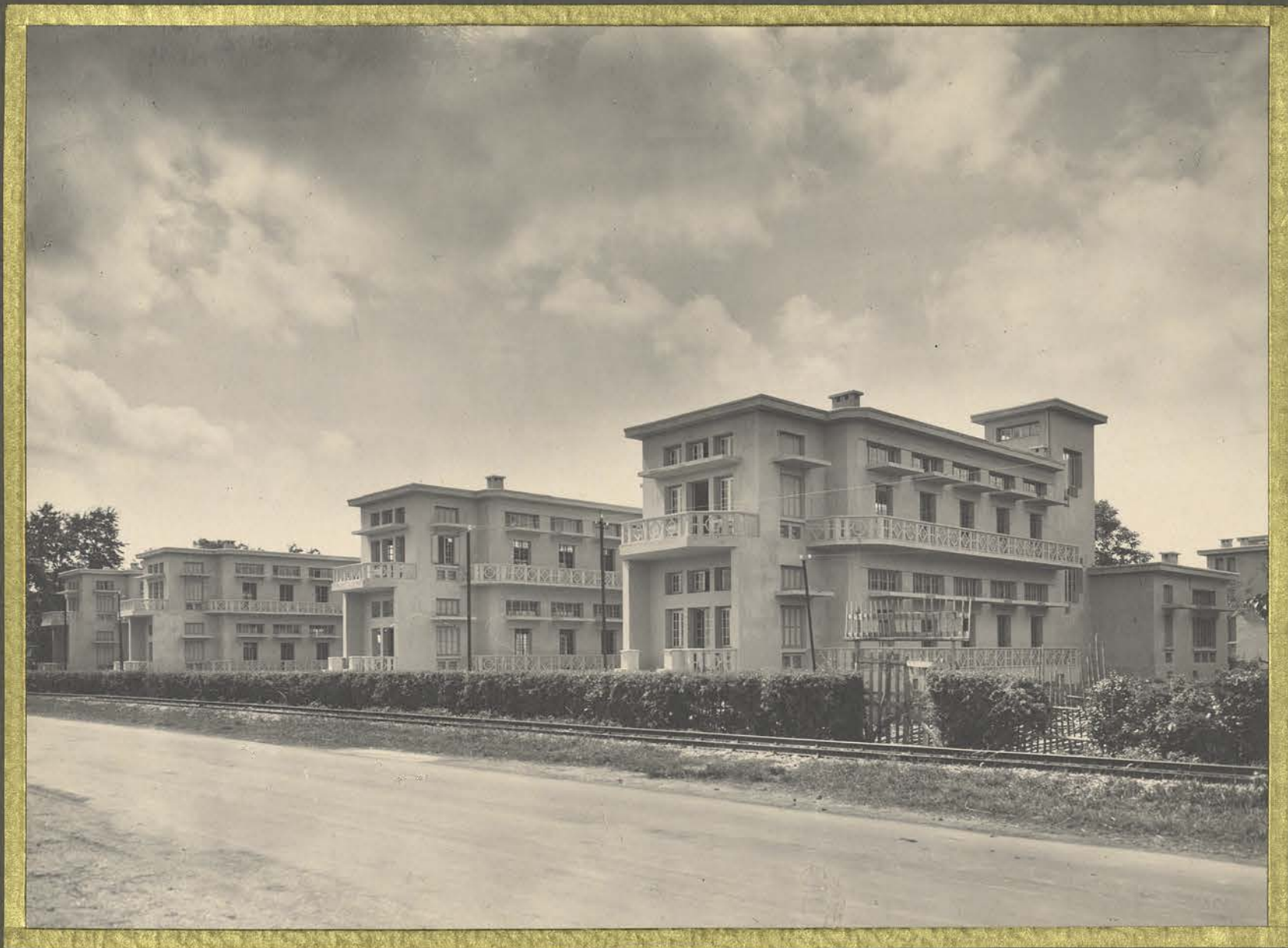
Quai environs de Hanoi. L'hôpital R. Robin.
