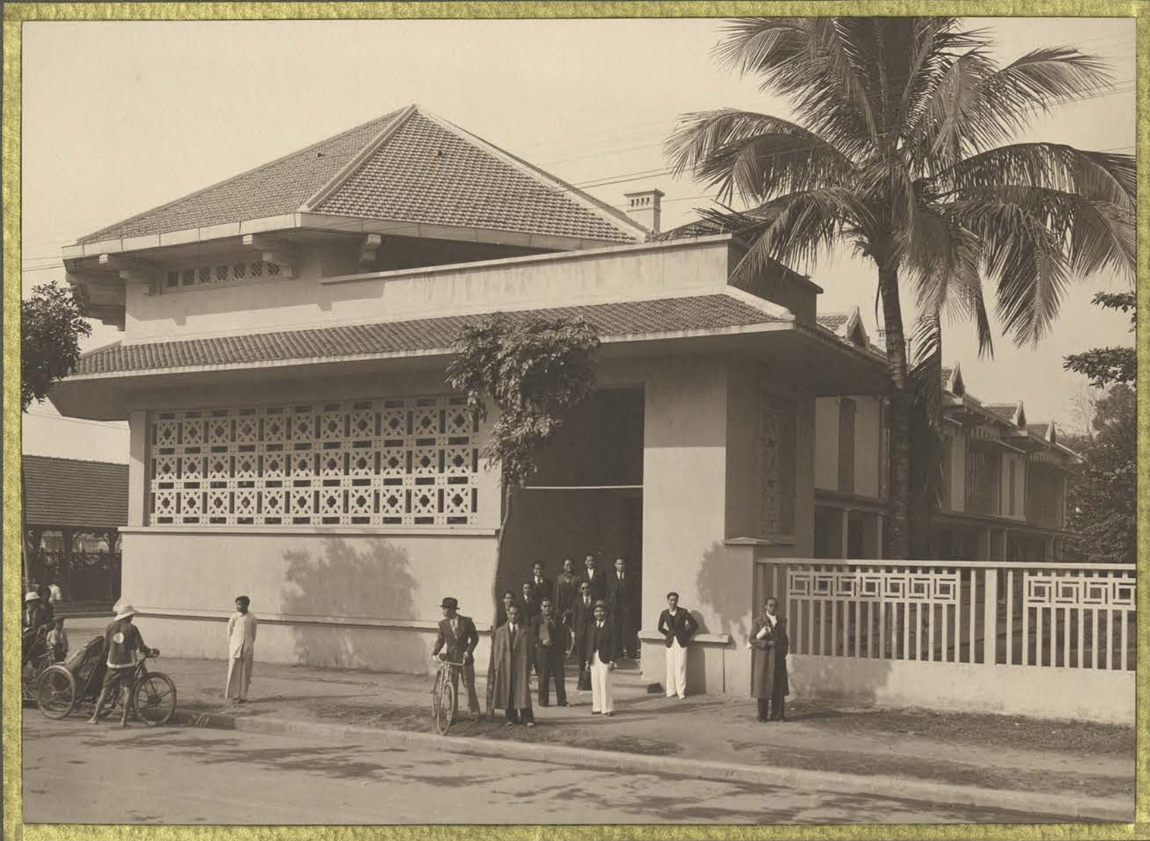
Hanoi. Ecole des Beaux Arts. Façade des ateliers.
