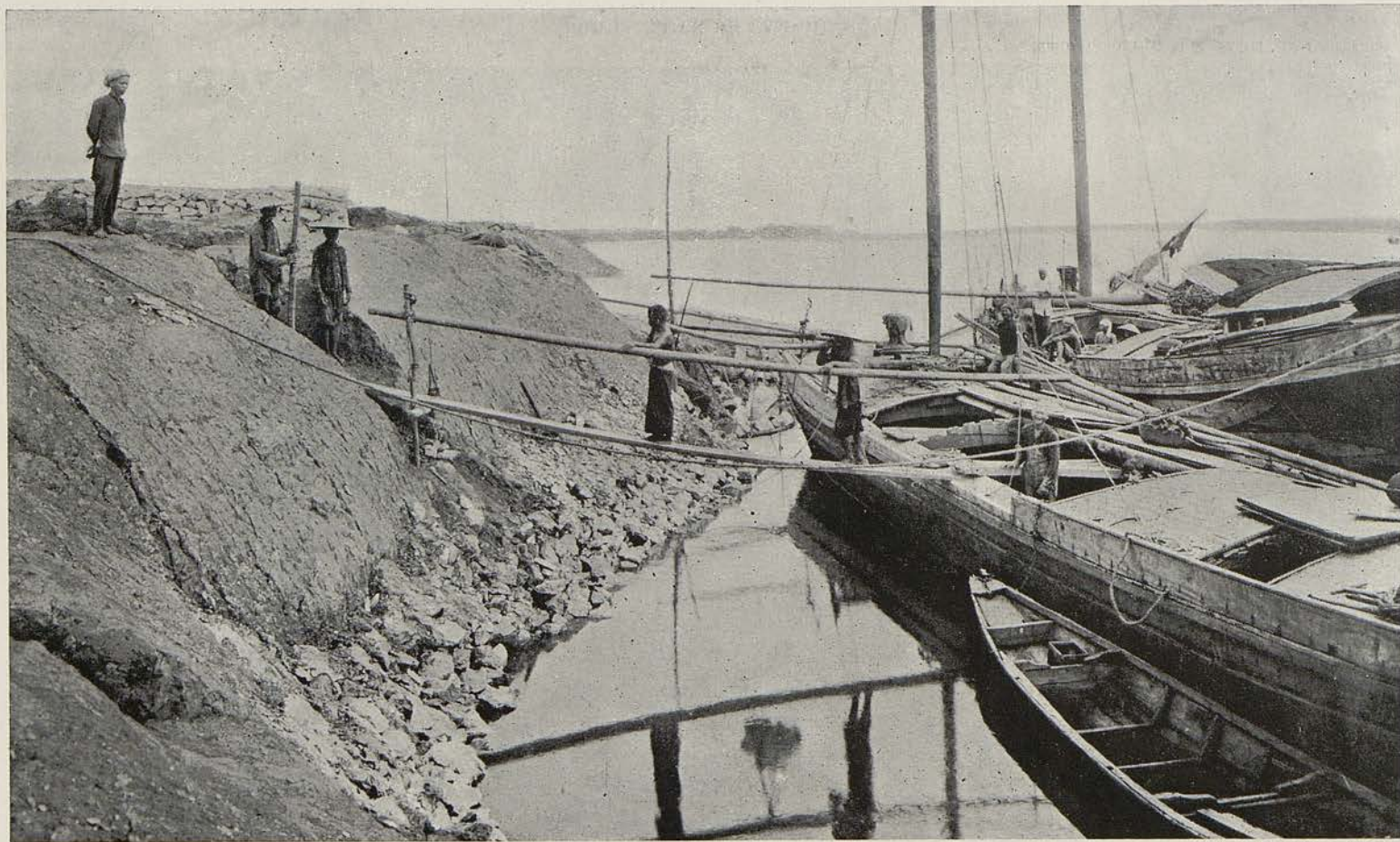
TRAVAUX D'ENTRETIEN DU POINT FIXE DE VINH-XUAN (Hadông)
