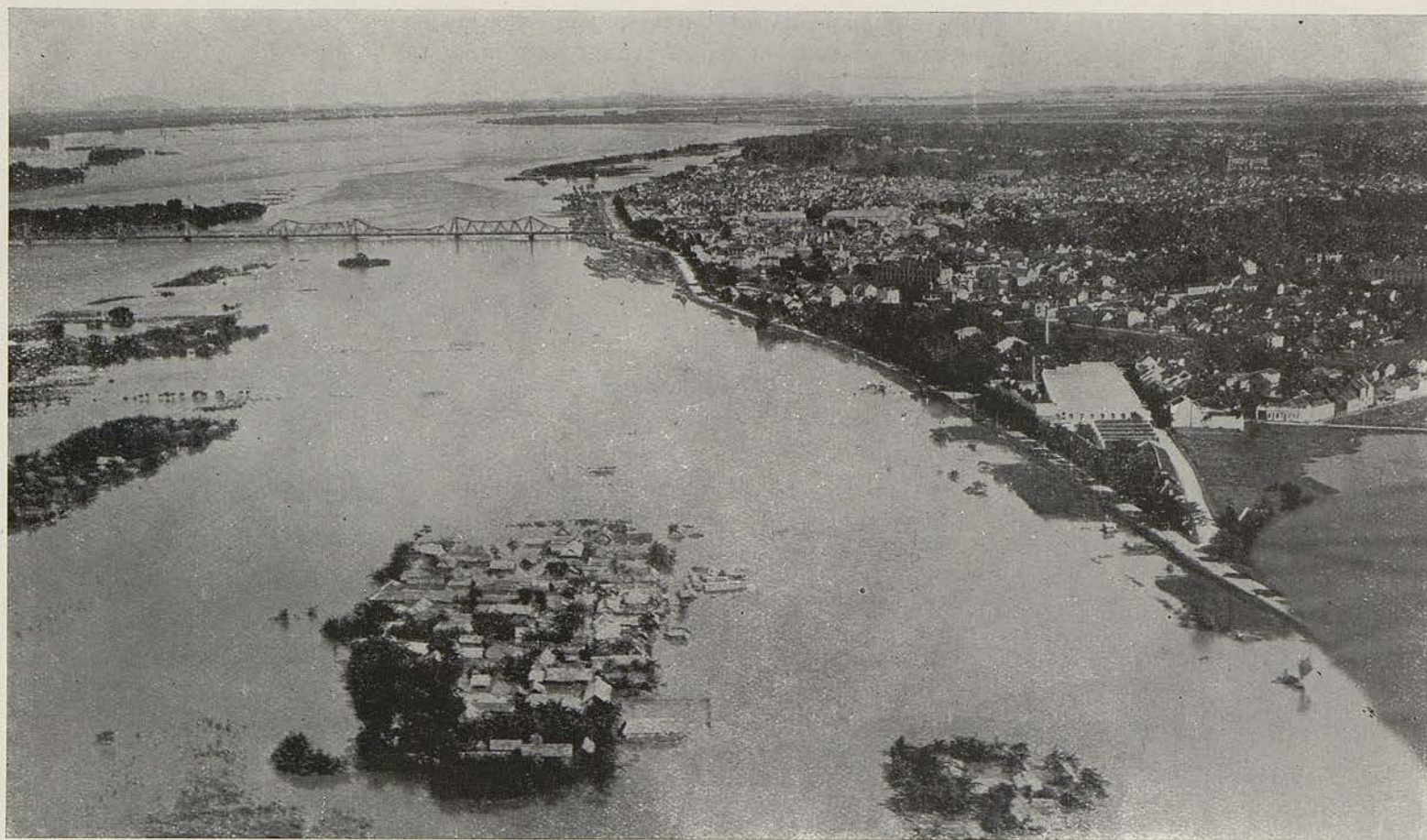
LIT MAJEUR DU FLEUVE ROUGE PENDANT LA CRUE DE 1926 (vue prise à l'amont d'Hanoi)
