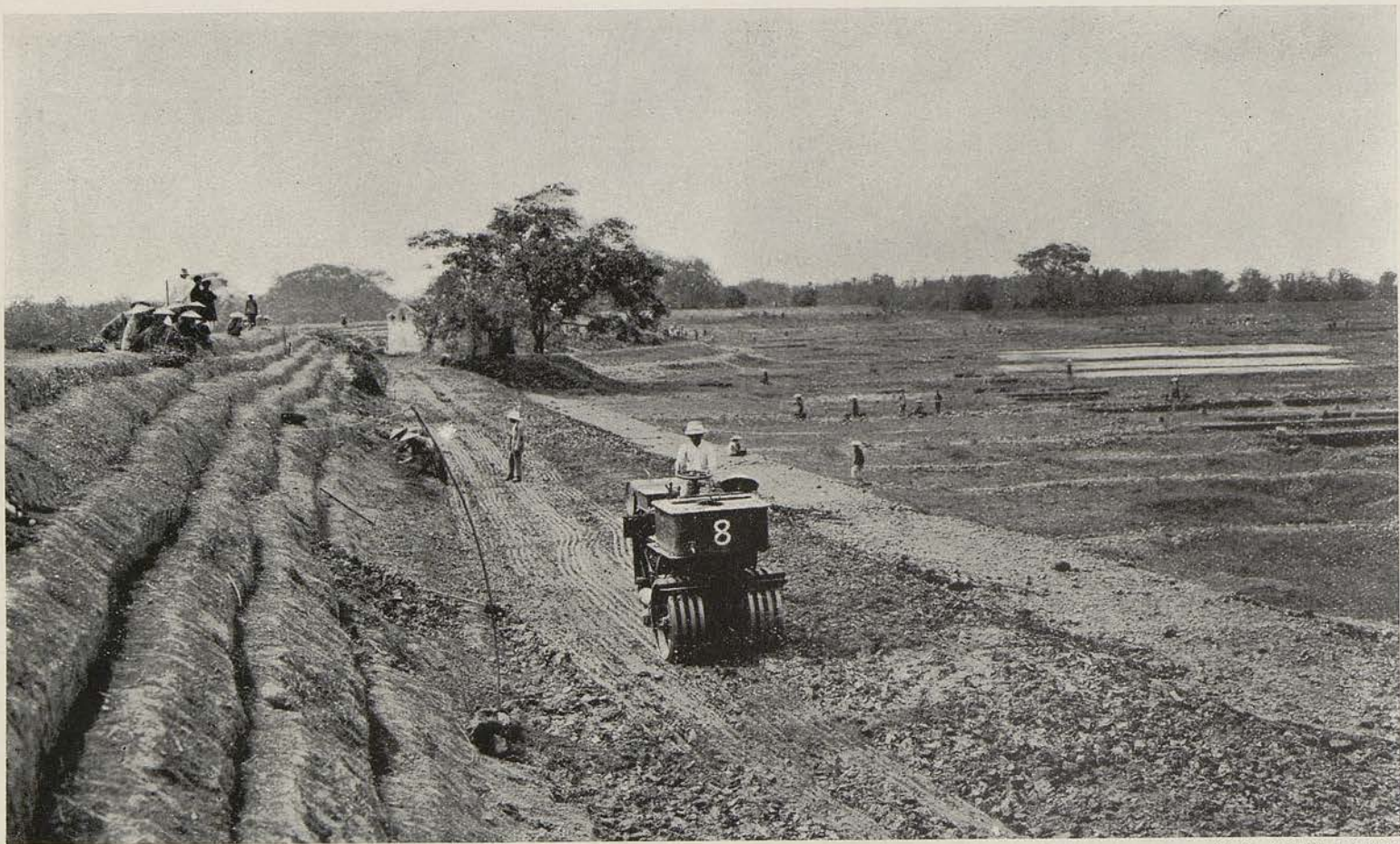
MASQUE CORROYÉ EN COURS D'EXÉCUTION (on voit, à gauche les redans pratiqués dans le talus de la digue à étancher, à droite une banquette de pied en remblais ordinaires)
