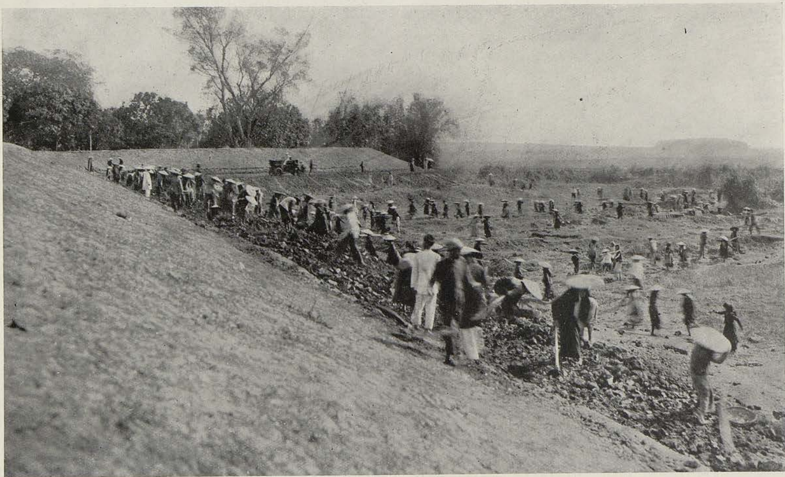
CHANTIER DE CORROYAGE EN PLEINE ACTIVITÉ
