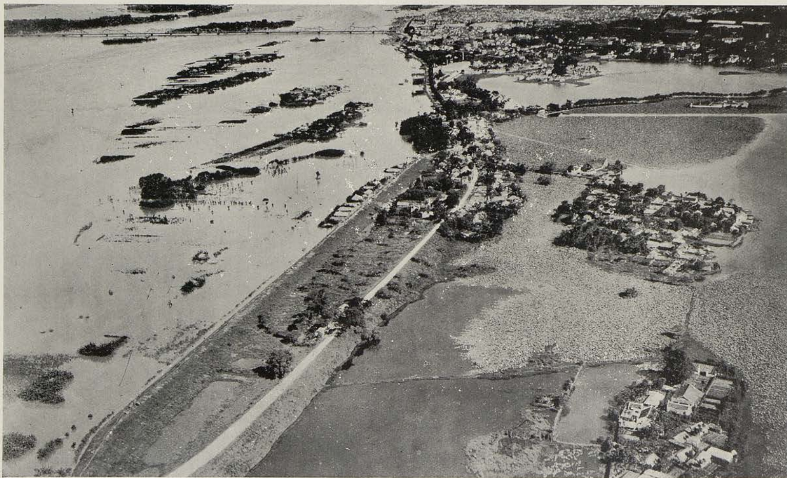
DIGUE EN CHARGE A L'AMONT D'HANOI EN JUILLET 1926
