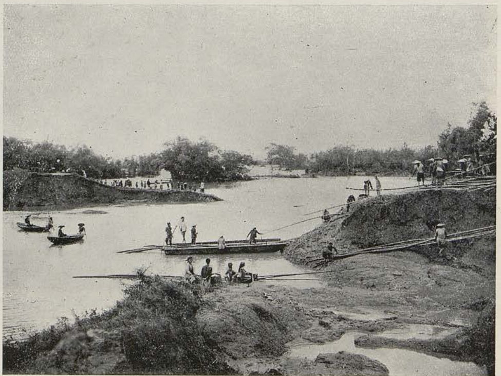
BRÈCHE APRÈS L'INONDATION DU CASIER
