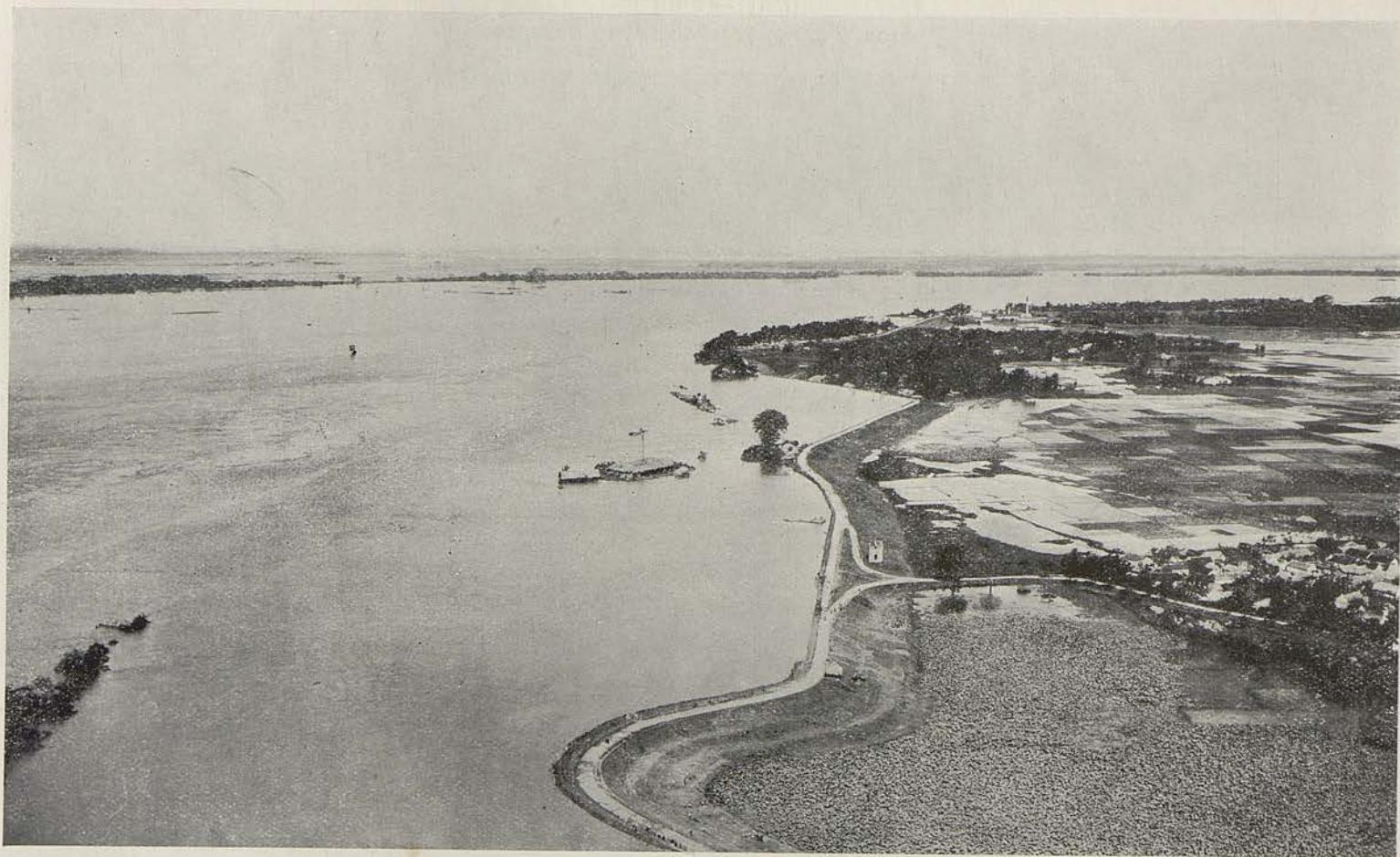
DIGUE EN CHARGE A L'AVANT D'HANOI EN JUILLET 1926
