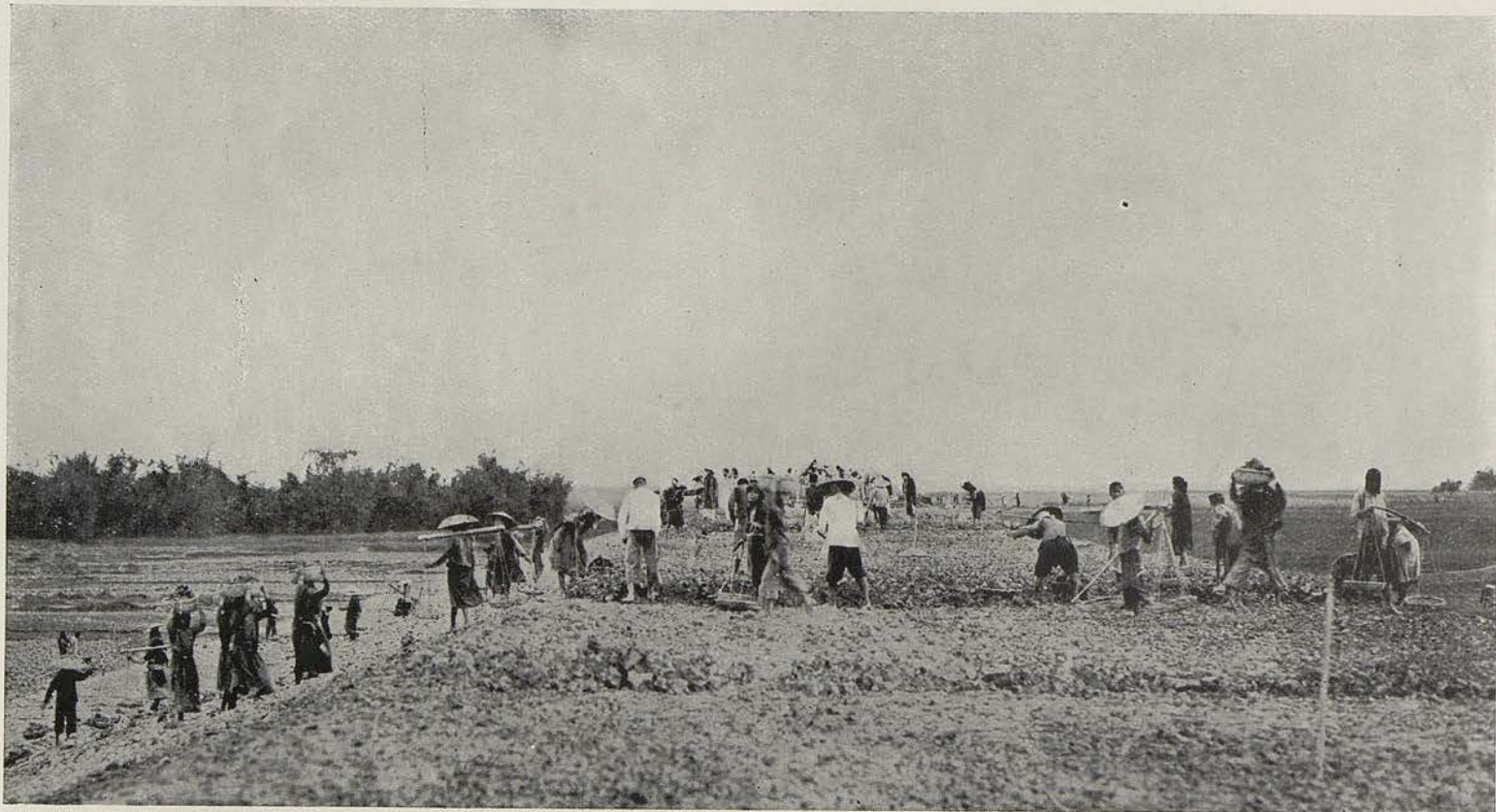
CHANTIER DE REMBLAIS ORDINAIRES (Contre-digue de Thi-Thôn, rive gauche du Canal des Rapides)
