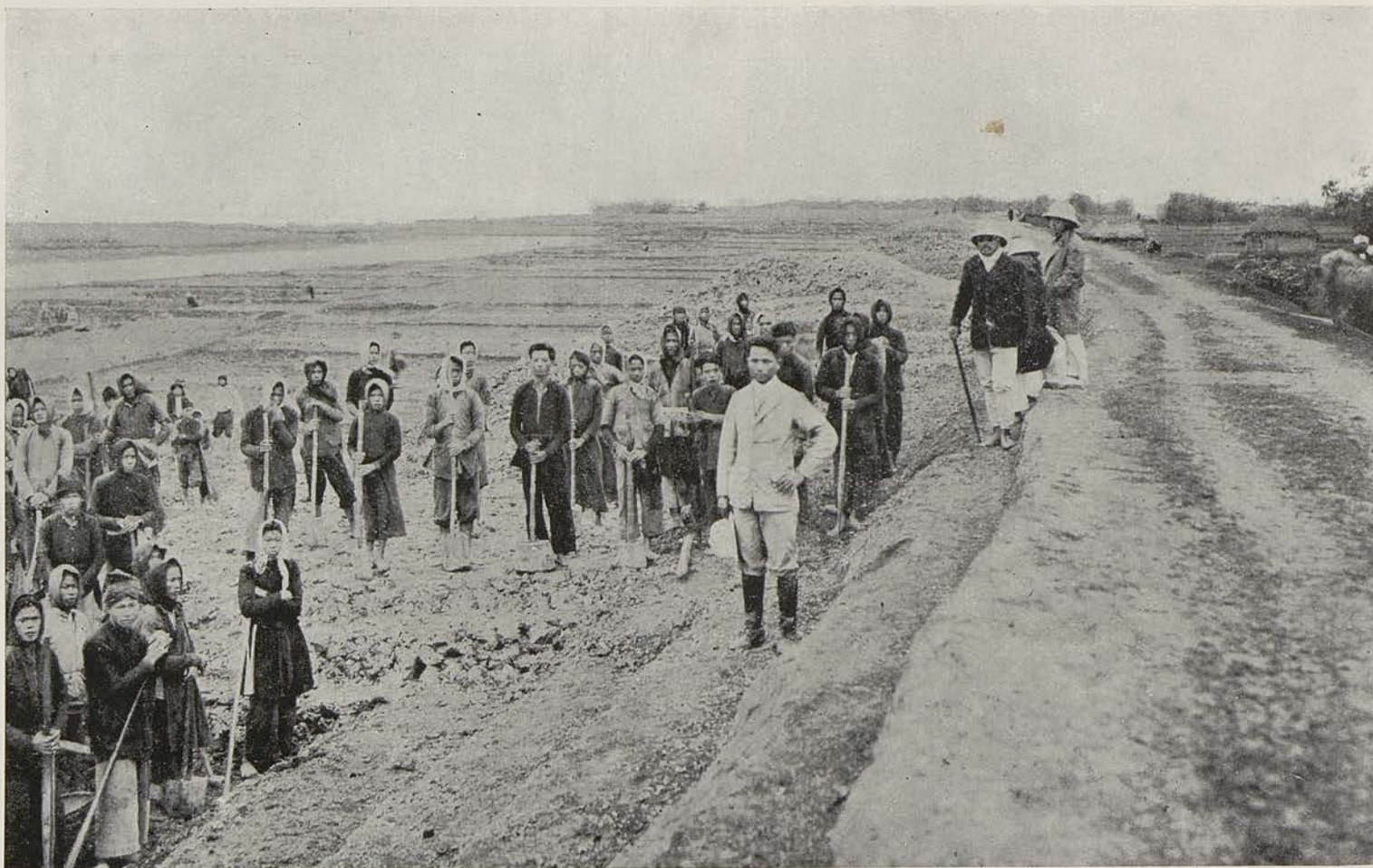
RENFORCEMENT EN REMBLAIS ORDINAIRES (Digue rive droite du Canal des Rapides)
