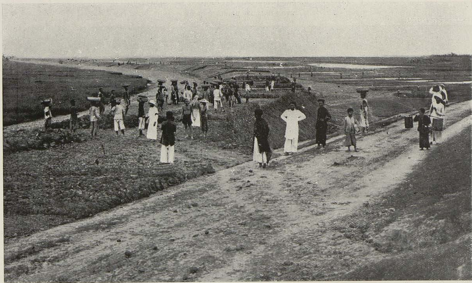
EXÉCUTION DE LA DIGUE NEUVE DE NHU-TRAC (1 re phase des travaux, remblais ordinaires) ; (à droite la digue actuelle).
