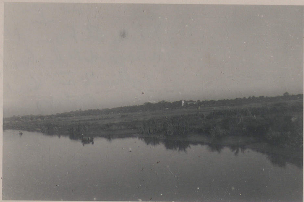
SAIGON.- Vue du pont sur l'arroyo de l'Avalanche (extrémité rue Chasseloup Laubat, vers l'amont.
