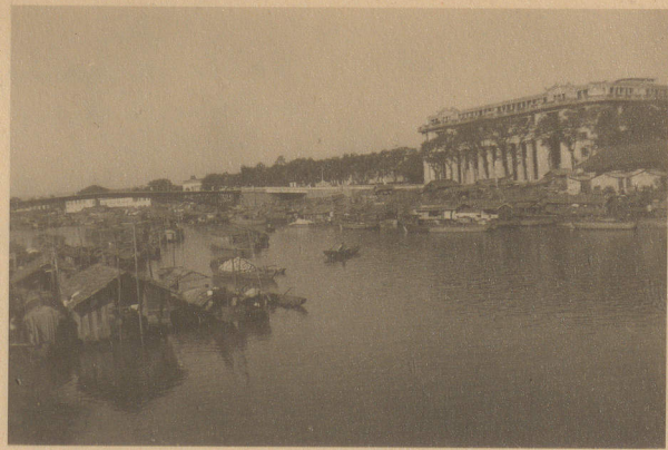
SAIGON, janvier 1950.- L'arroyo chinois vu du pont Guynemer, vers l'amont. (Le pont Pellerin; a dr. la Banque de l'Indochine).
