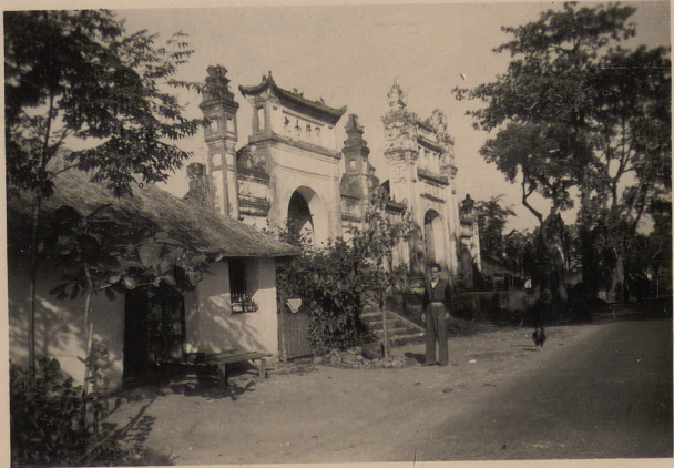
Route du village du Papier, mai 1952.- Porte d'entrée du village de Ho Khau.
