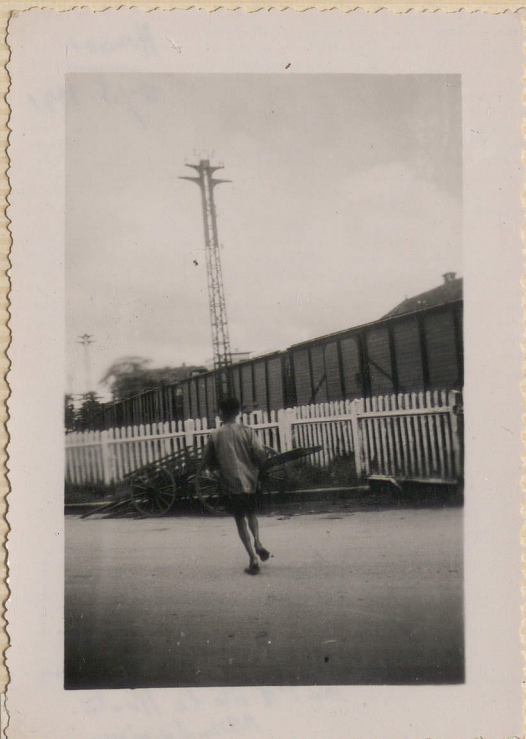
HANOI, septembre 1951.- Passage d'un train au Passage à Niveau de la Route Mandarine.
