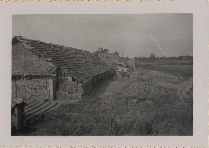
Briquetterie aux abords de la Route circulaire, près de Thinh Quang (S-O de Hanoi).- septembre 1953.
