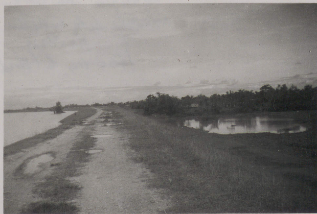
Digue du Day, septembre 1953.- La... à hauteur de la route de Ha Dong.
