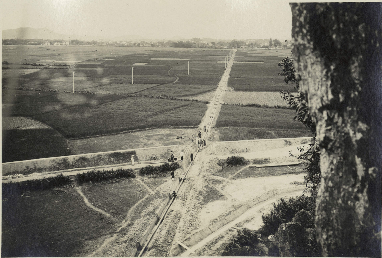
II - POSE DE LA CONDUITE D'AMENEE EN ACIER.
