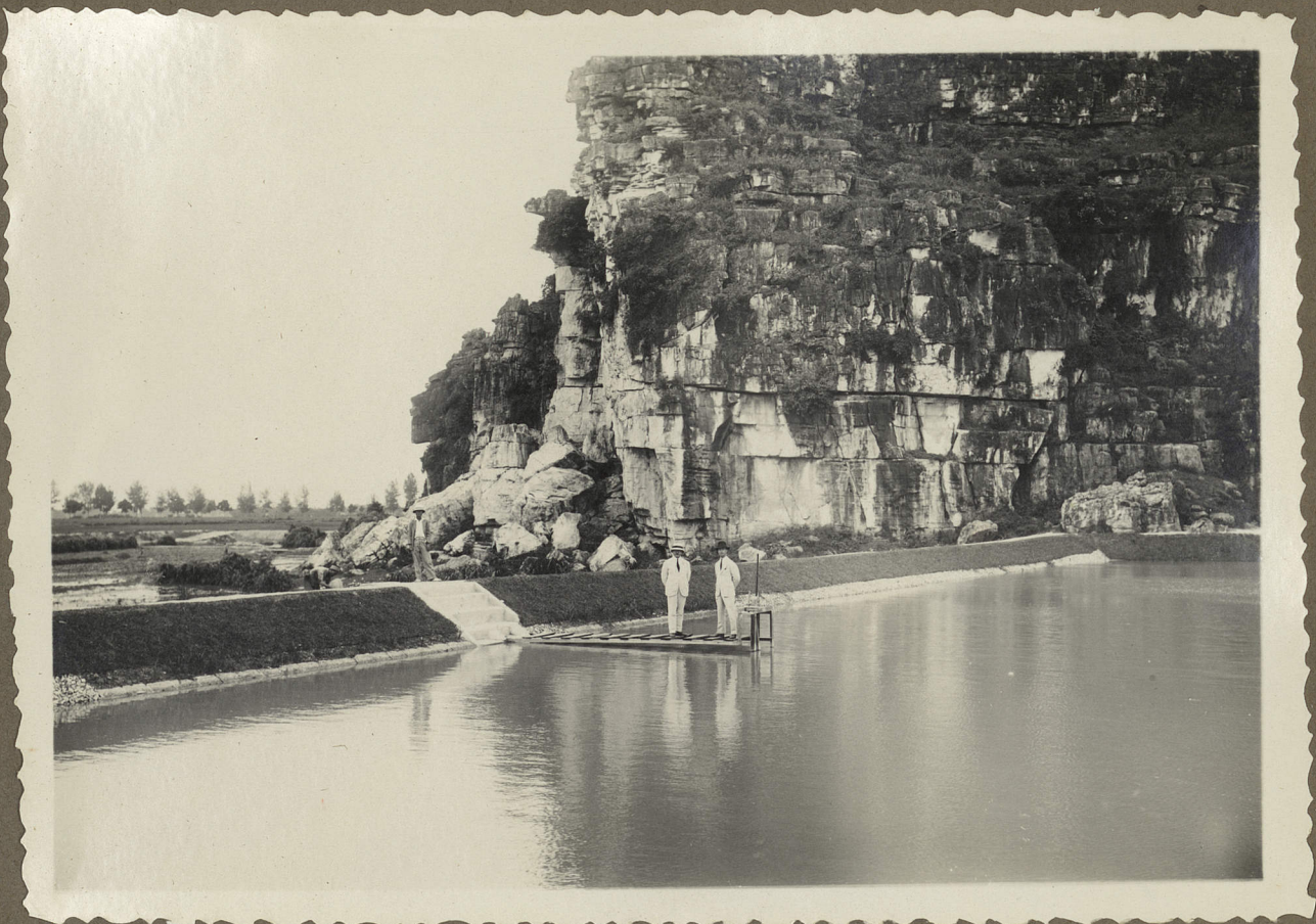
3. - PRISE D'EAU DES FILTRES.
