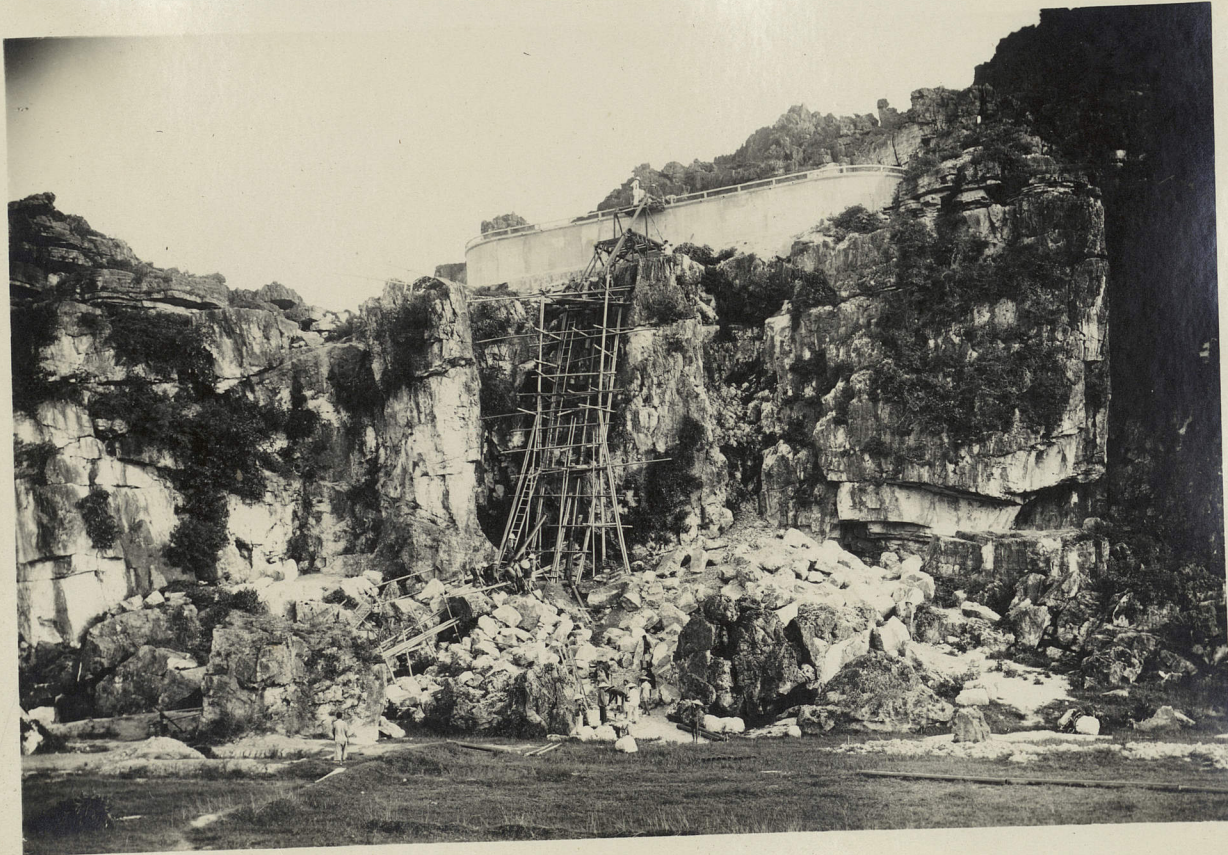
9 - POSE DES TUYAUX DE REFOULEMENT & DE DISTRIBUTION.
