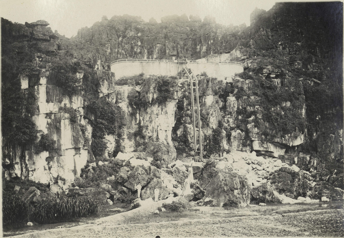
10 - VUE DU RESERVOIR DE 500 m 3 TERMINE.
