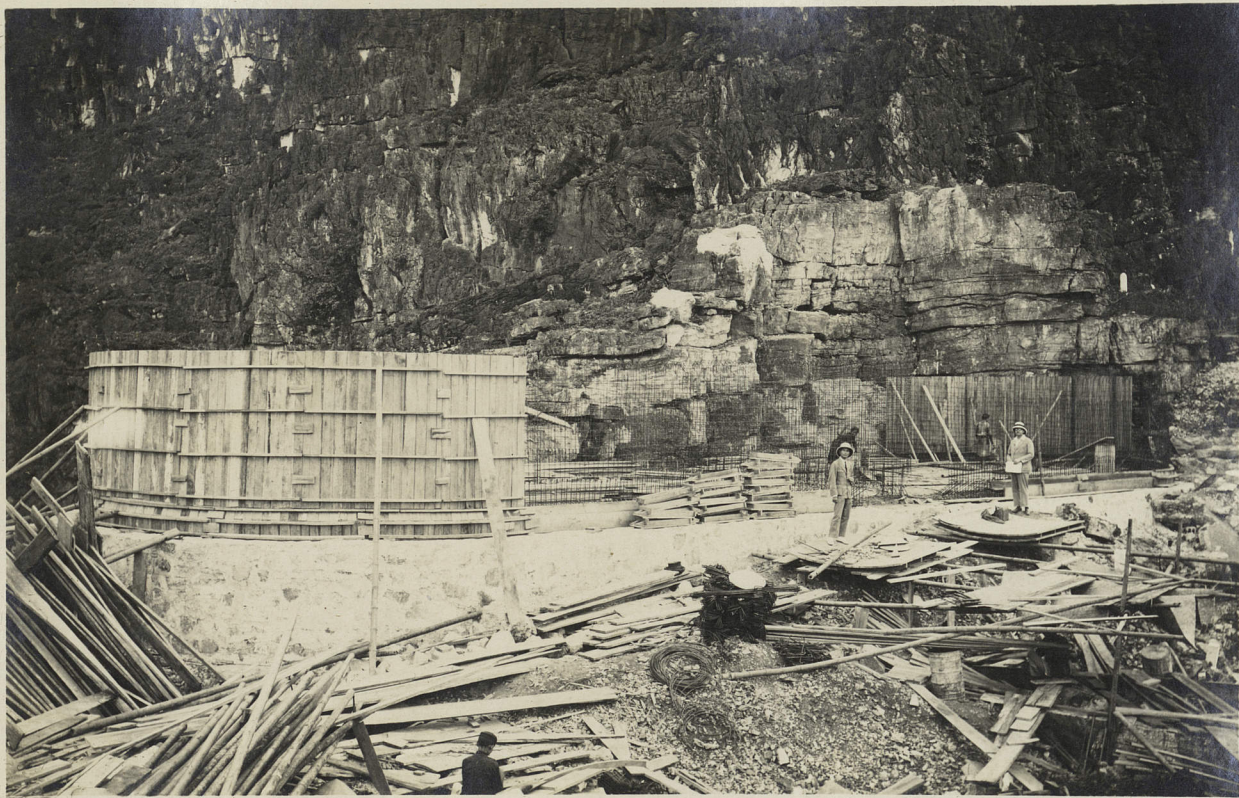
8 - CONSTRUCTION DU RESERVOIR DE 500 m3 (Extérieur)
