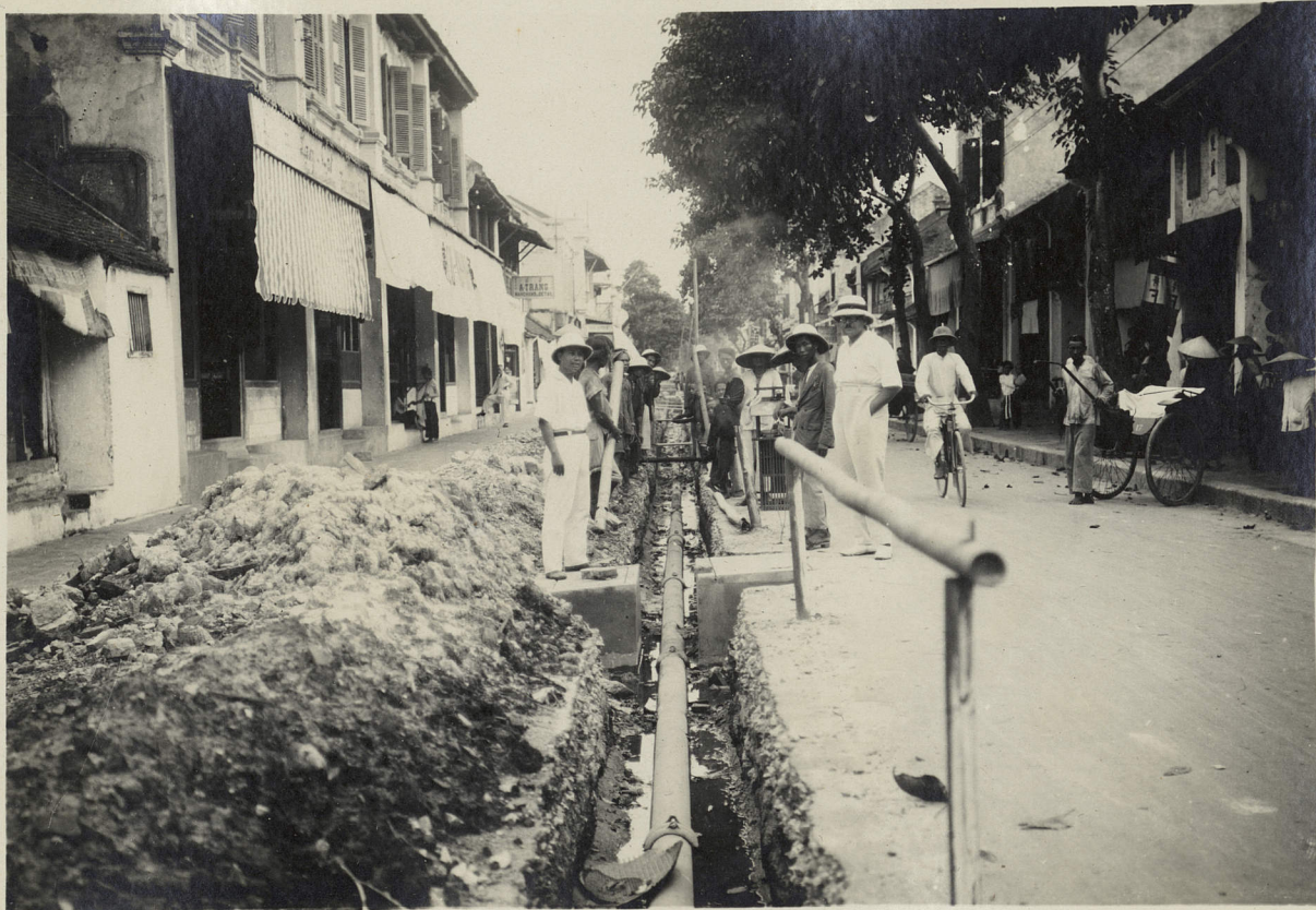
I3 - TRANCHEE DE POSE DES CONDUITES EN FONTE.
