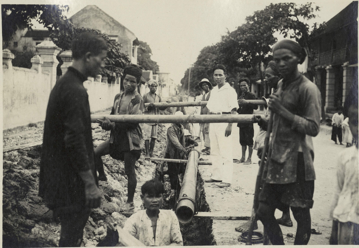
I4 - POSE DES CONDUITES EN FONTE.
