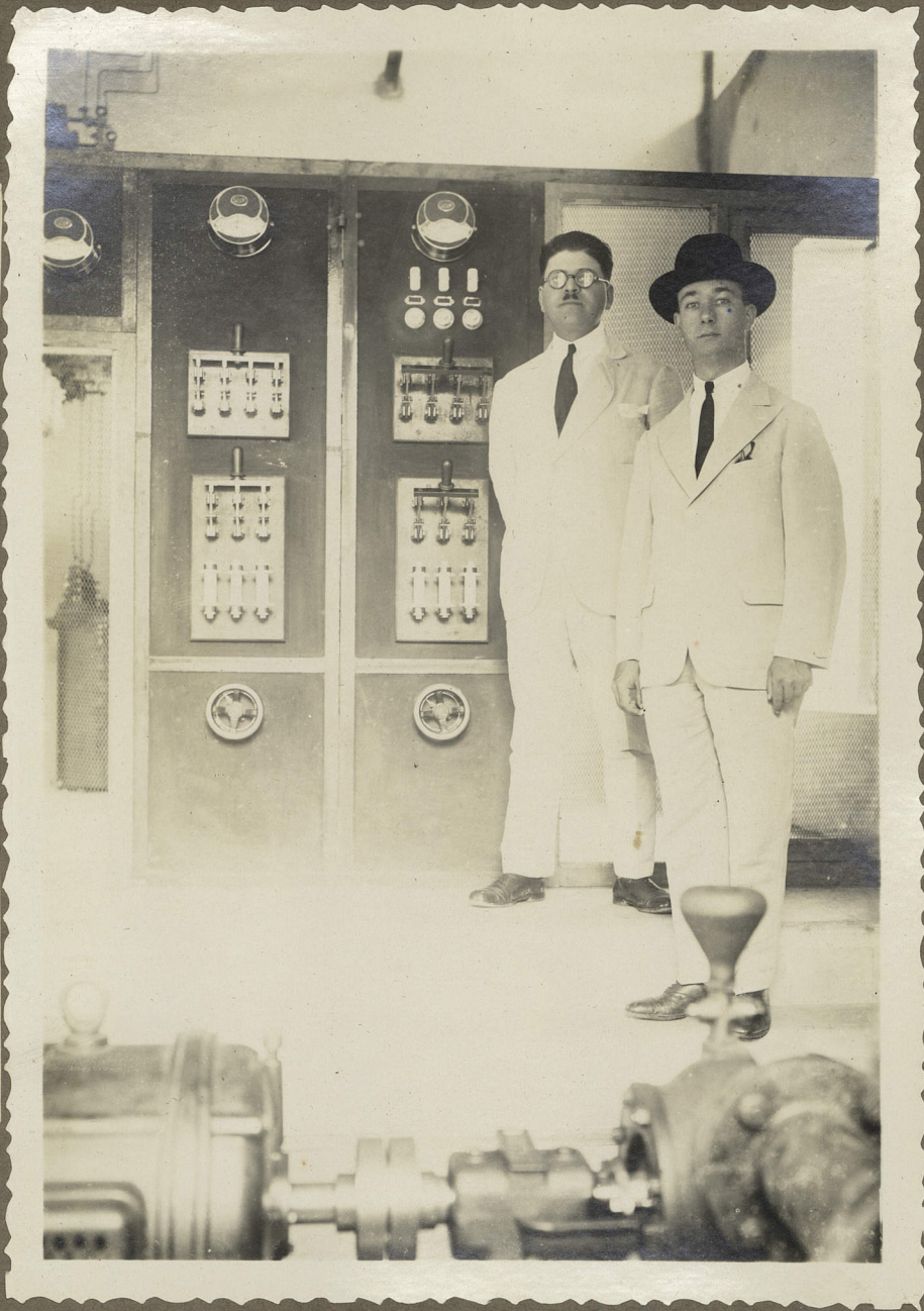
6 - TABLEAU & POMPE DU POSTE DE POMPAGE.
