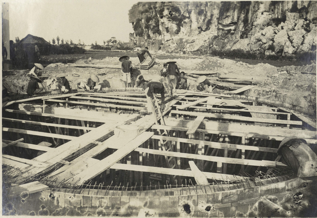
4 - CONSTRUCTION DE LA BACHE EN BETON ARME.
