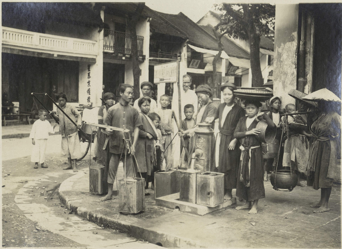
16 - DISTRIBUTION DE L'EAU POTABLE PAR UNE FONTAINE.
