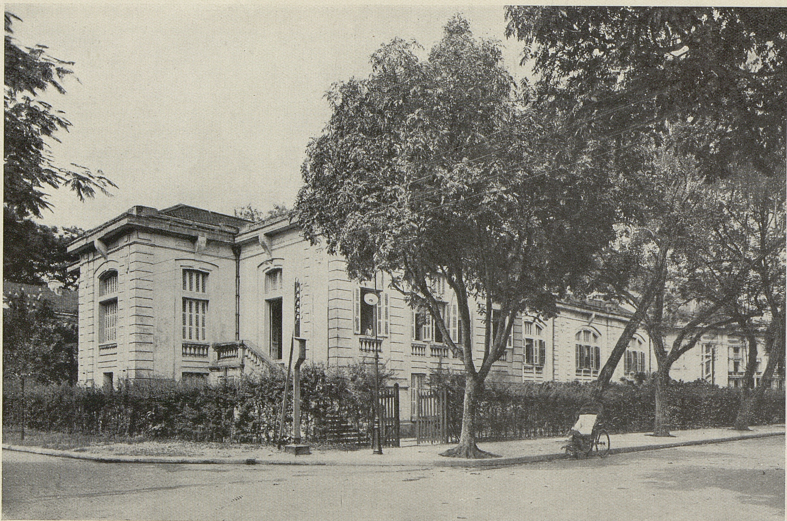
HANOI. — Inspection générale des Mines et de l'Industrie. Bâtiment des Laboratoires.
