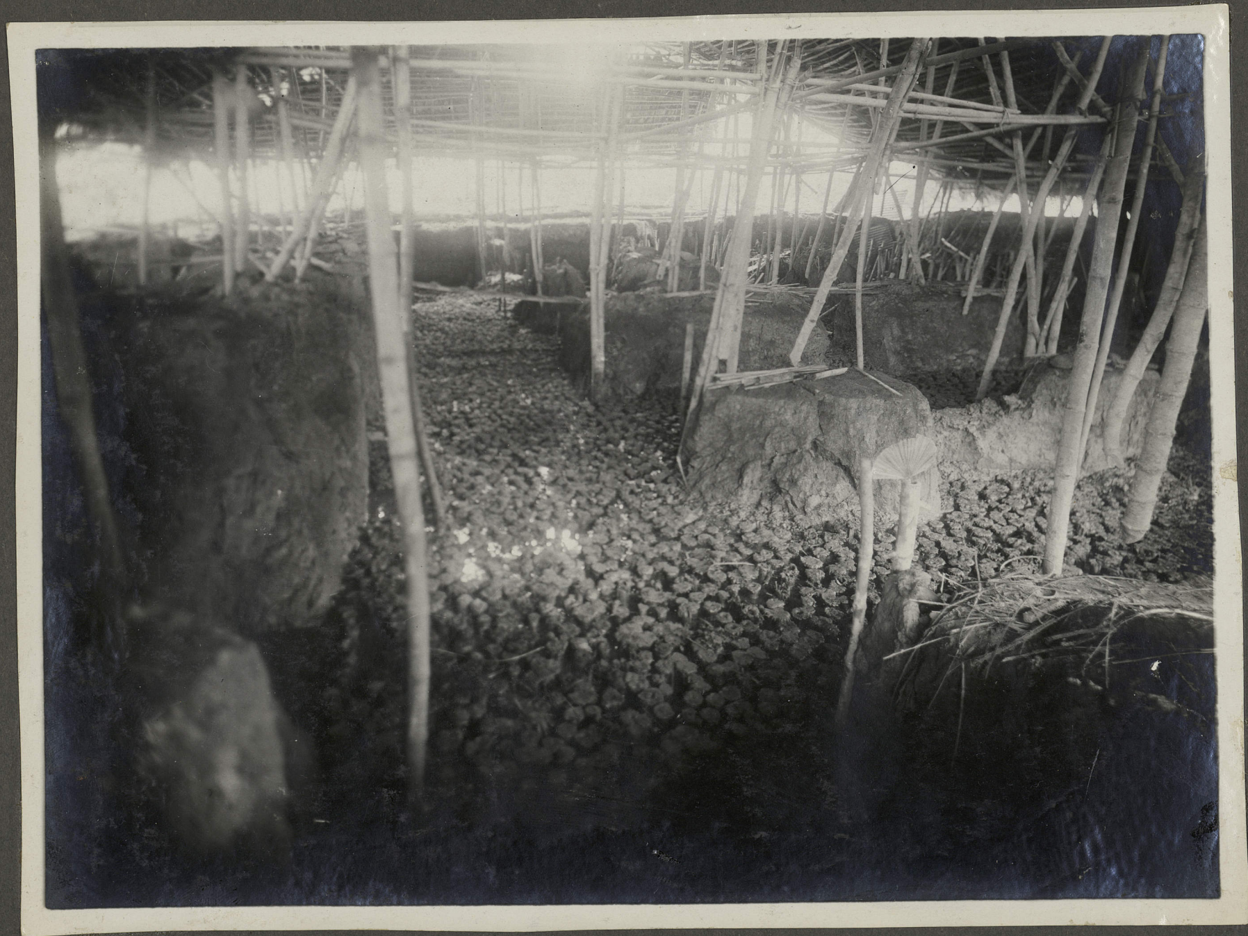
16.000 Bambous sont enfoncés dans la vase pour soutenir le futur Batiment .
