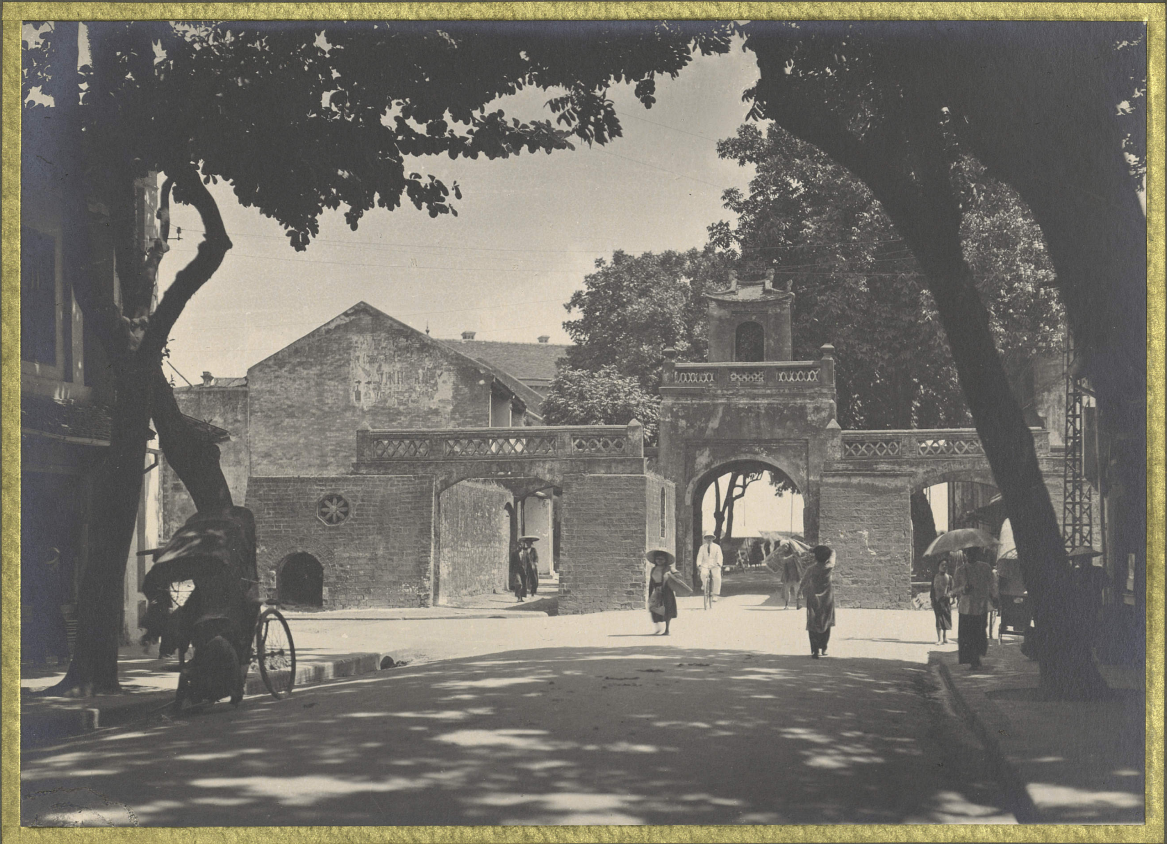
Hanoi . Le portique de la rue Jean Dupuis .
