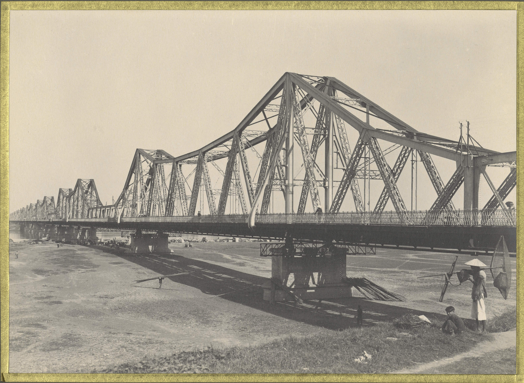
Hanoi. Le pont Doumer.
