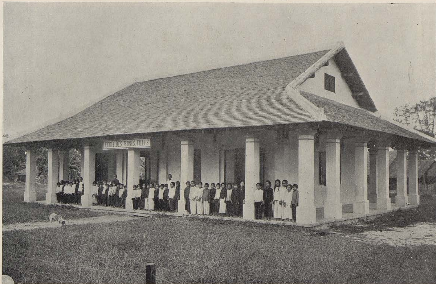
THO NOT, PROVINCE DE LONGXUYEN UNE ÉCOLE ÉLÉMENTAIRE DE FILLES A DEUX CLASSES. CONSTRUCTION EN BRIQUES SUR UN TERRE-PLEIN MAÇONNÉ AVEC VÉRANDA CIRCULAIRE
