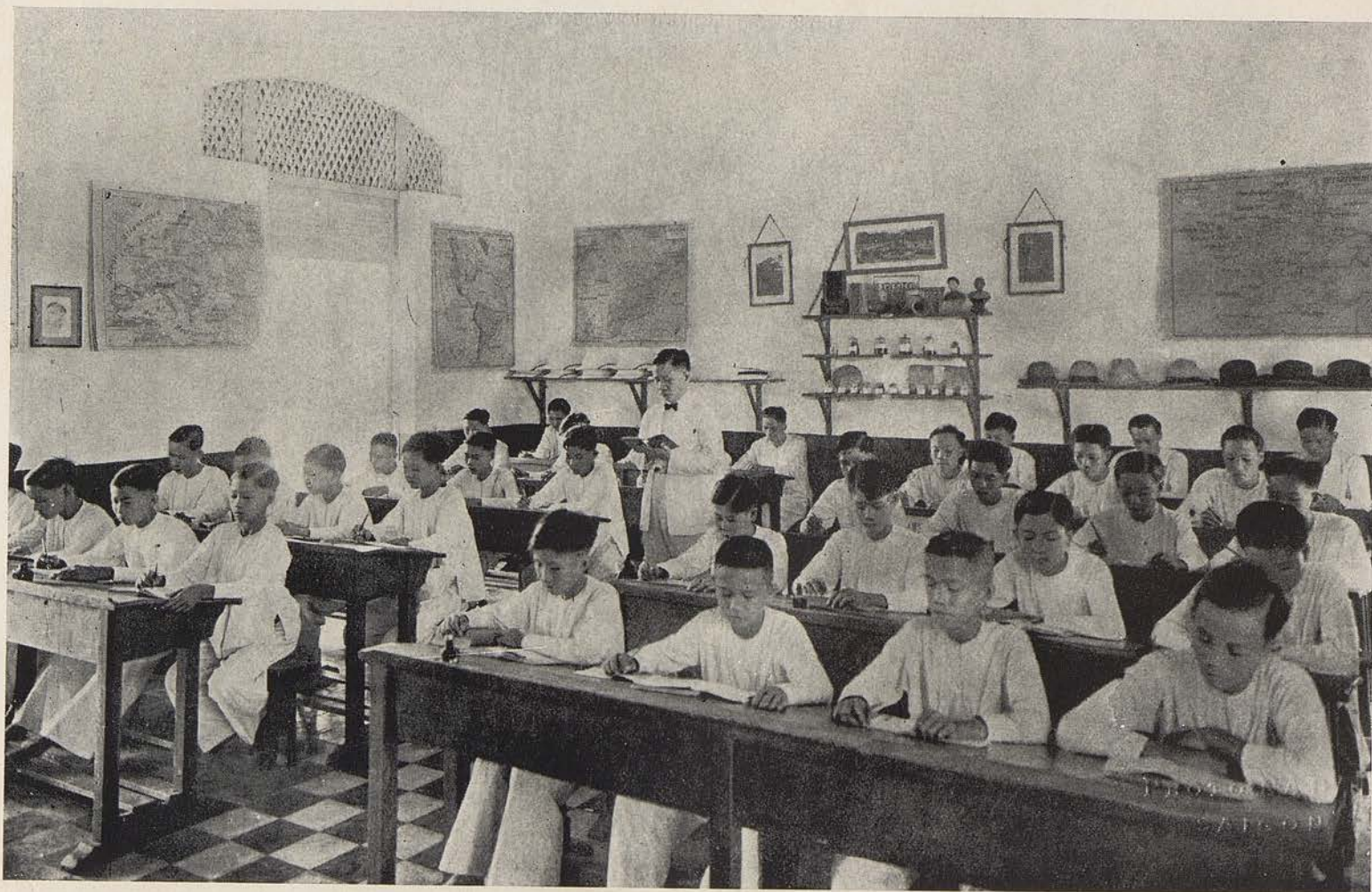
INTÉRIEUR DE CLASSE A TRAVINH.
