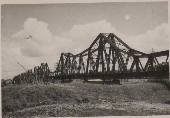
HANOI.- Le Pont Doumer.
