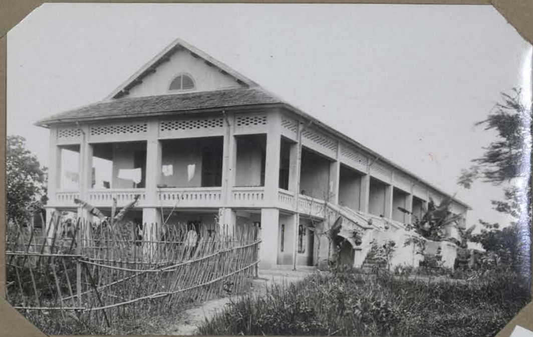
Tong. - Logement des sous-officiers mariés.
