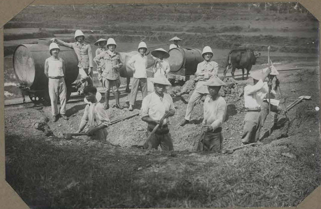
Tong. - Travaux à la voie ferrée
