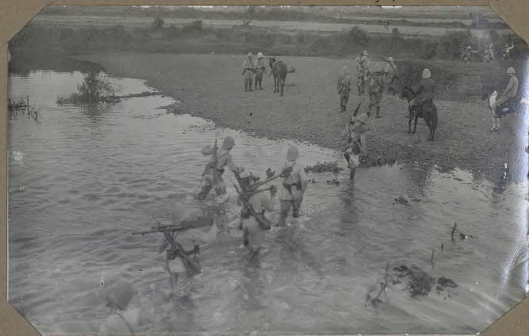
En manœuvre: Franchissement d'un arroyo par les C. M. 4.
