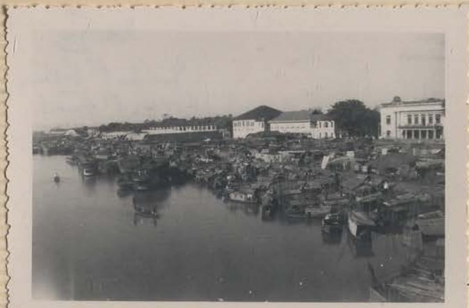
SAIGON.- Vue du Pont Pellerin vers l'amont.
