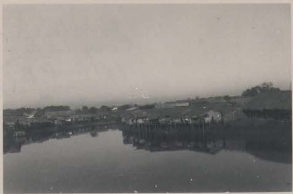
SAIGON. Vue du pont sur l'arroyo de l'Avalanche (pl. Maréchal Foch) vers l'amont.
