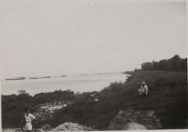
HANOI. Le Fleuve en crue le 2 septembre 1954 jusqu'au pied de la grande digue.
