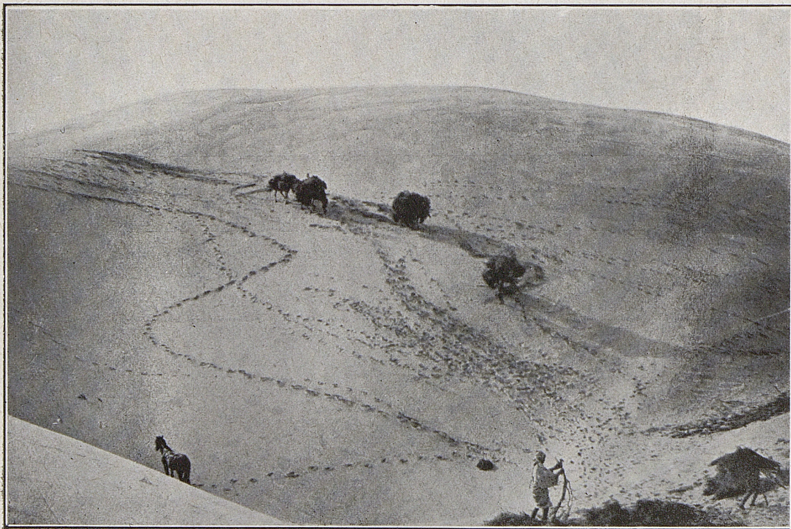
Figure 4. — Une grande dune : Transport de matériaux de couverture
