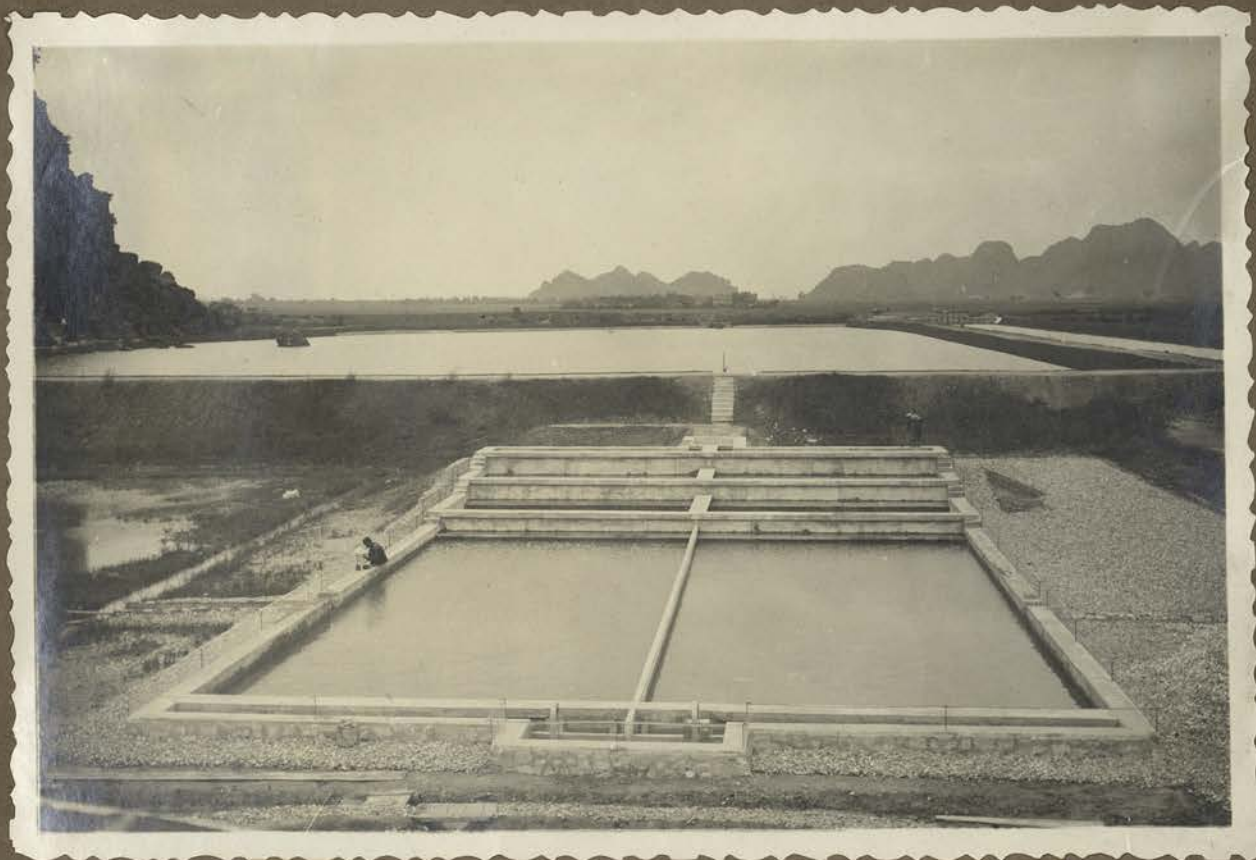
I - BASSIN DE DECANTATION & FILTRES.
