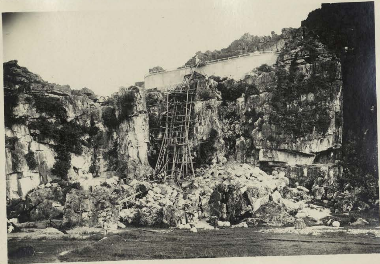
9 - POSE DES TUYAUX DE REFOULEMENT & DE DISTRIBUTION.
