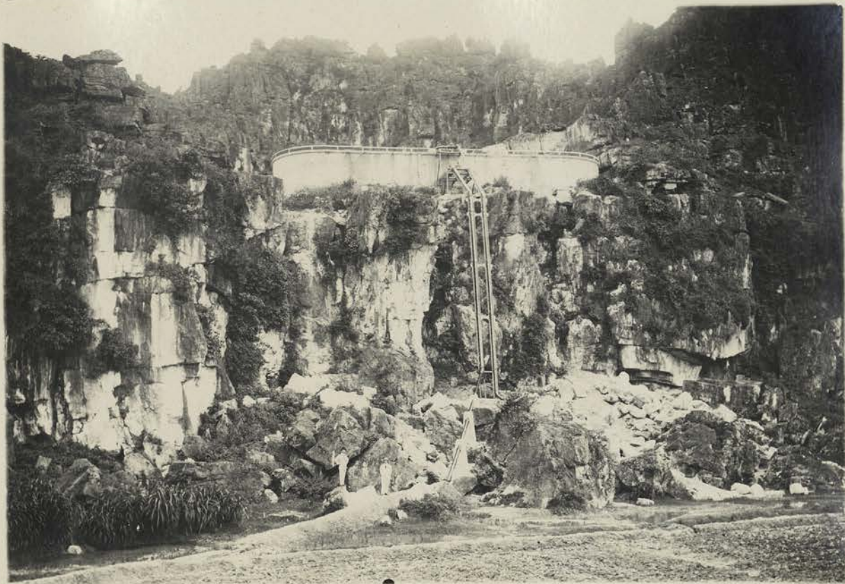
10 - VUE DU RESERVOIR DE 500 m 3 TERMINE.
