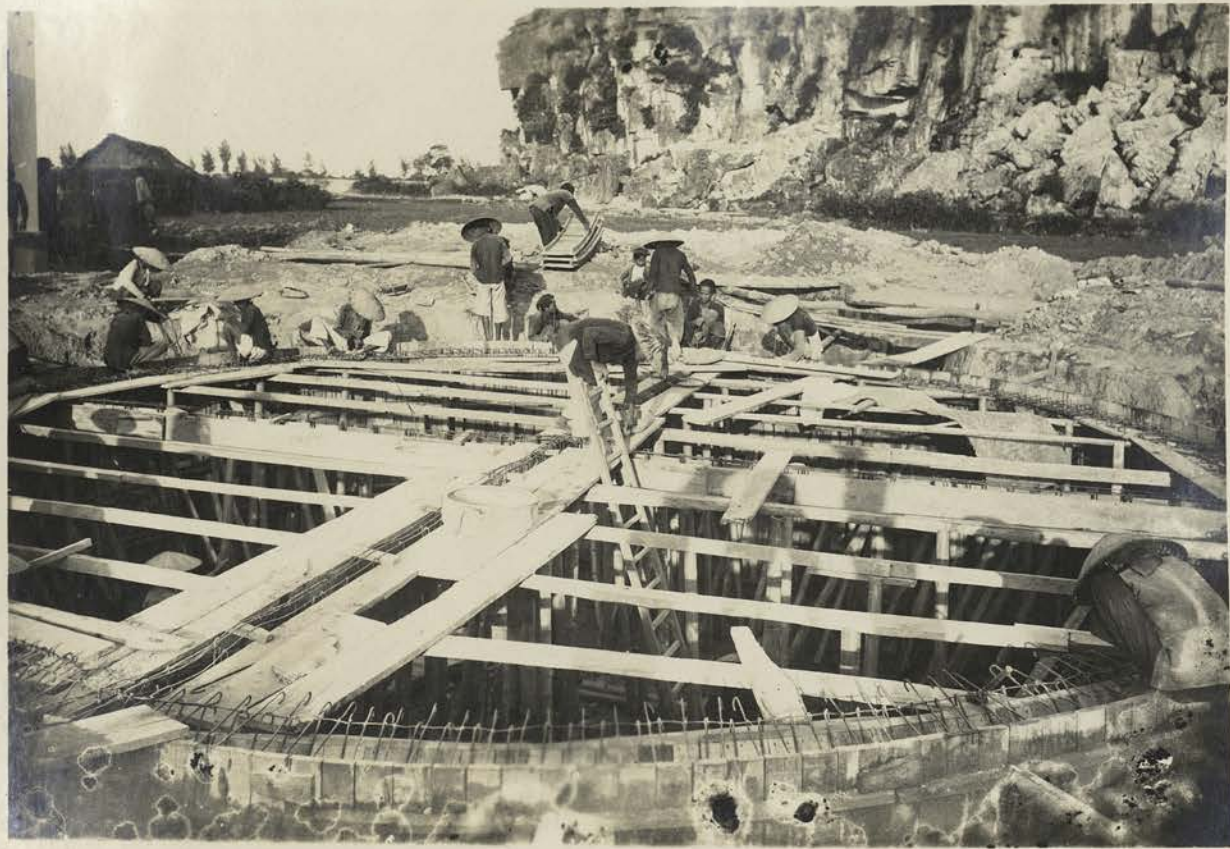
4 - CONSTRUCTION DE LA BACHE EN BETON ARME.
