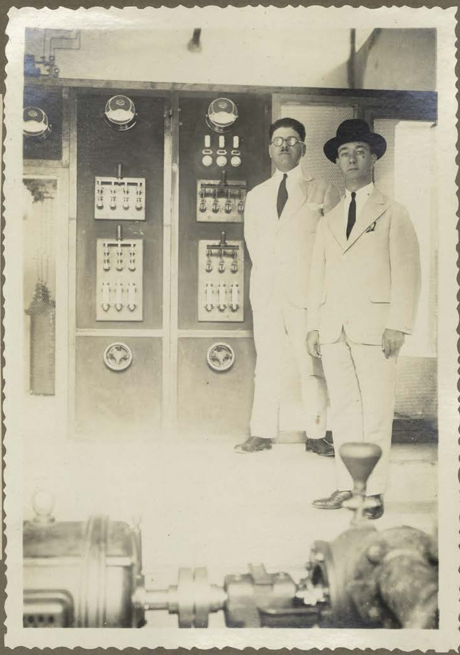
6 - TABLEAU & POMPE DU POSTE DE POMPAGE.
