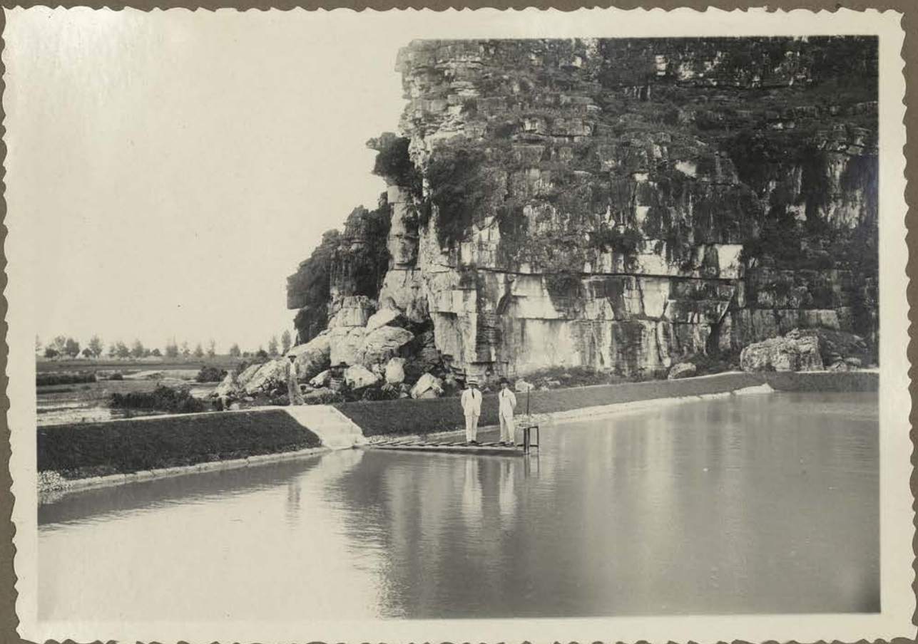
3. - PRISE D'EAU DES FILTRES.
