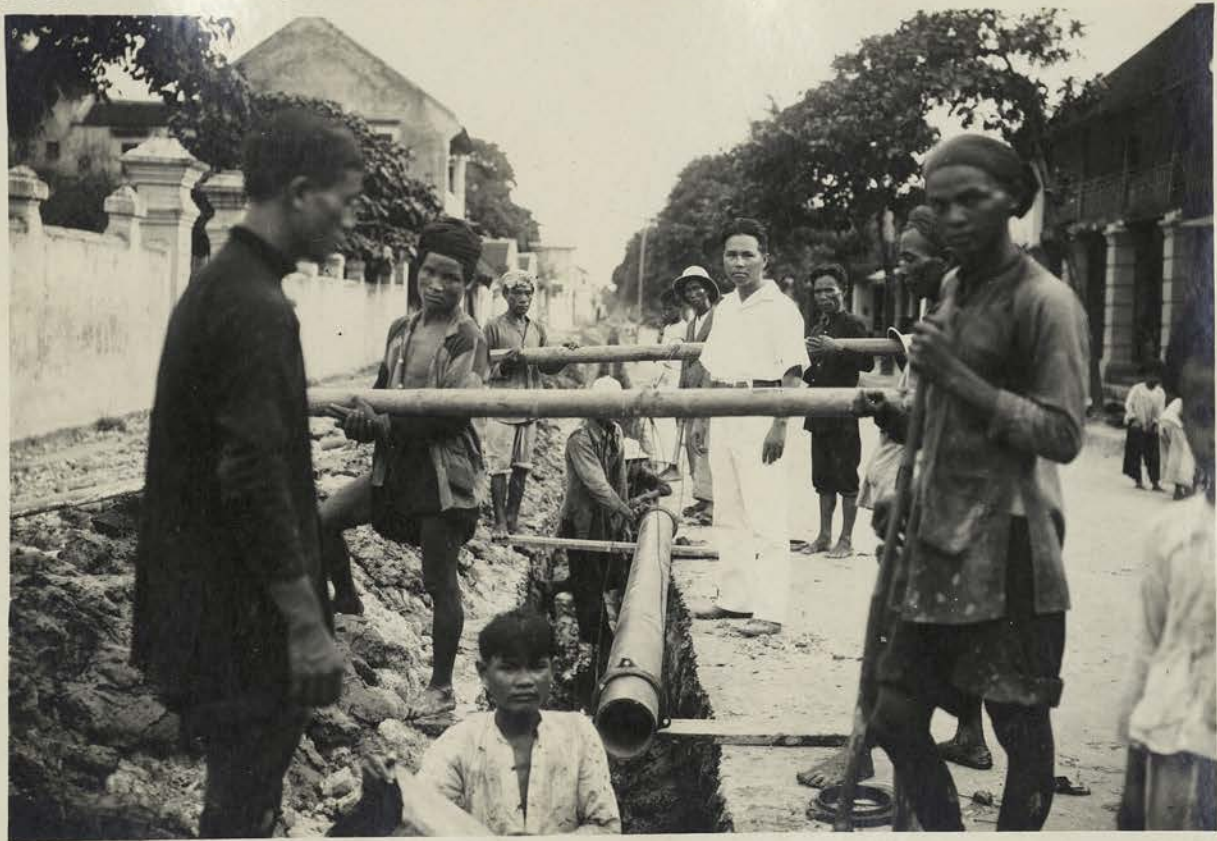
I4 - POSE DES CONDUITES EN FONTE.
