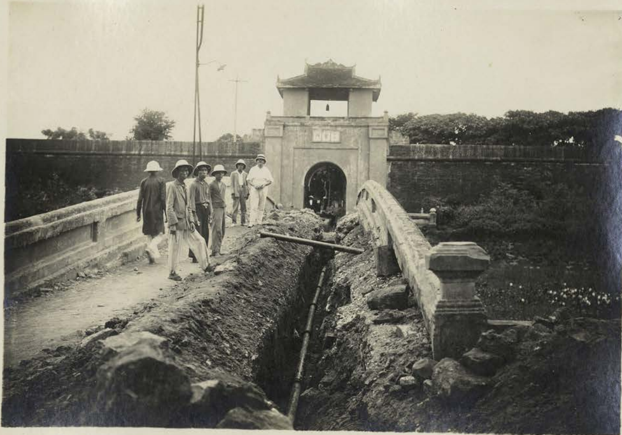
15 -POSE DE LA CONDUITE A L'ENTREE DE LA CITADELLE DE THANH-HOA ,BERCEAU DE LA FAMILLE IMPERIALE
