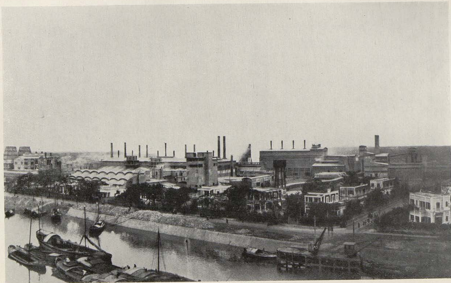
KIEN-AN. — Vue panoramique de la Cimenterie de Haiphong.
